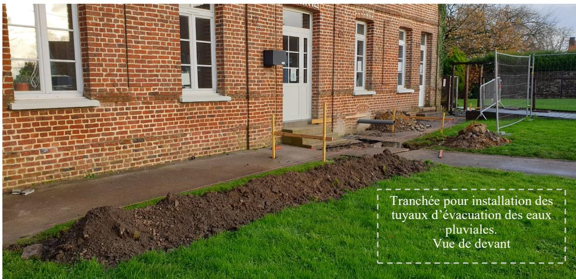
Tranchée pour installation des tuyaux d'évacuation des eaux pluviales.
