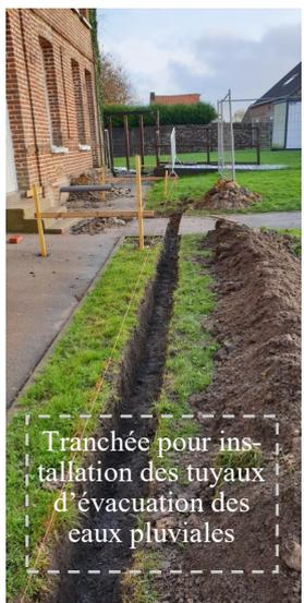
Tranchée pour installation des tuyaux d'évacuation des eaux pluviales
